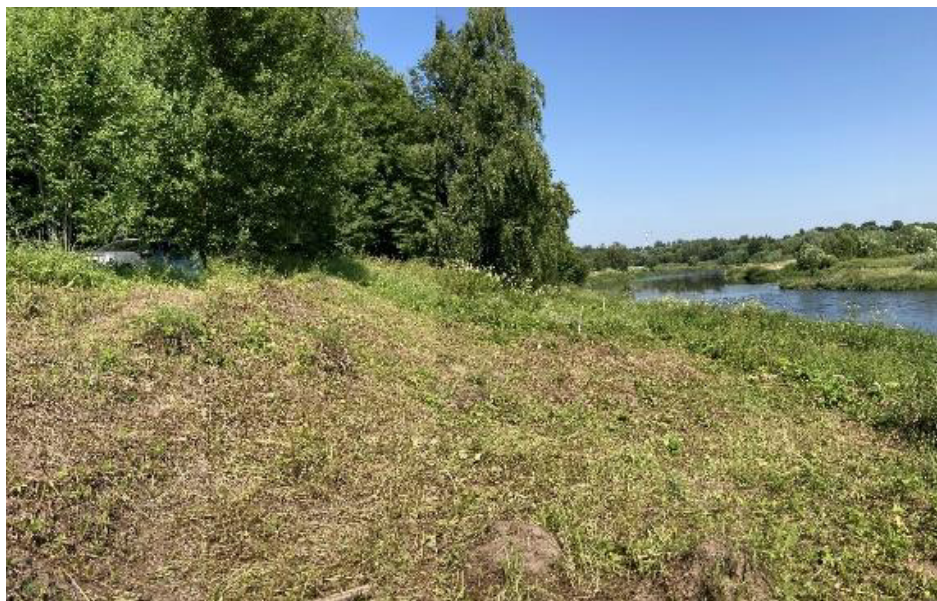
Рис. 4. Внешний вид западной части участка работ после удаления растительности (вид из центра участка)
