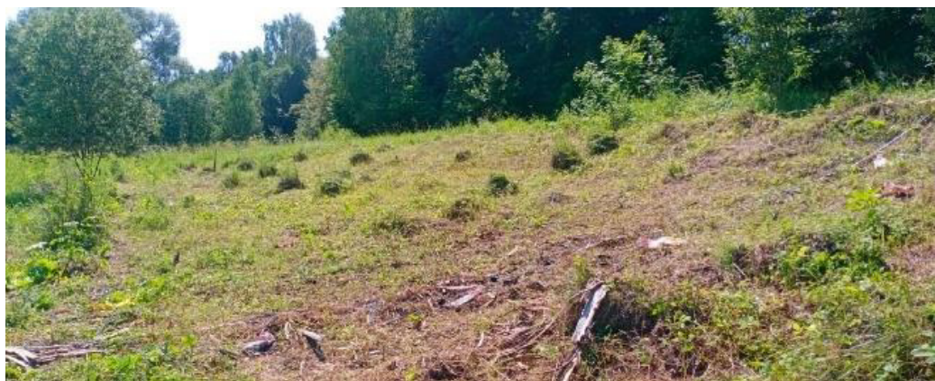
Рис. 5. Участок работ после удаления растительности (вид с СЗ угла)
